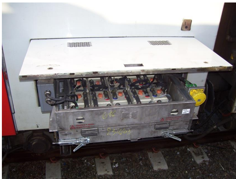
Photo 8 - M6 - Coffre batterie - Vue globale
