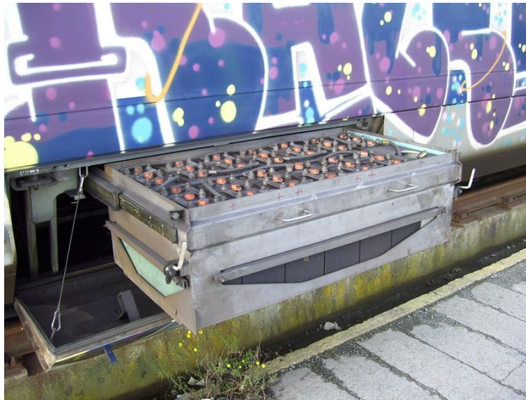
Photo 2 - AM96 - Coffre batterie - Vue d'ensemble
